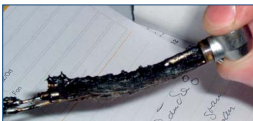
(Abb. 3) † ... weiter demontiert sieht es so aus.
